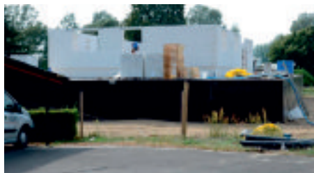
Trwają końcowe prace przy rozbudowie oczyszczalni ścieków
