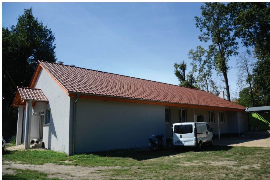
Budowa sali wiejskiej w Nowym Dworze
