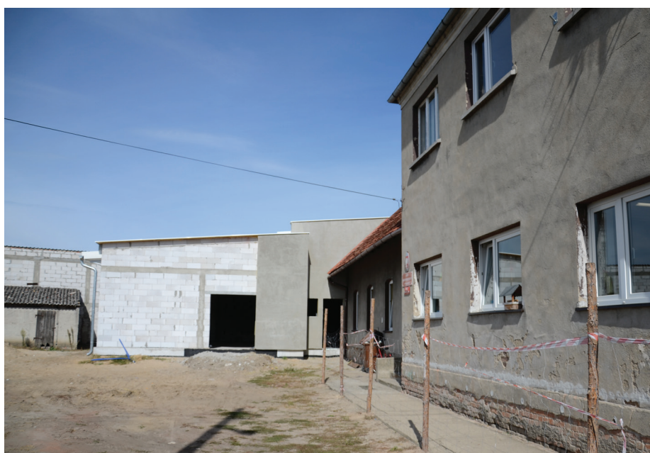
Budowa sali wiejskiej w Perzynch
