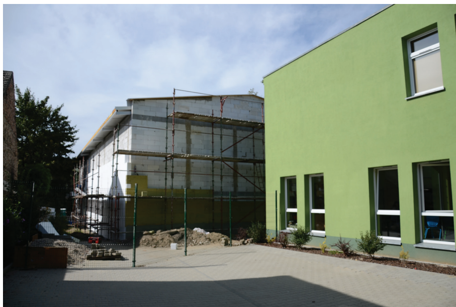
Budowa sali gimnastycznej w Przyprostyni
