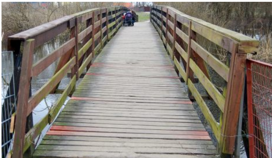
Niebawem nastąpi rozbiórka starej konstrukcji którą zastąpi nowa kładka
