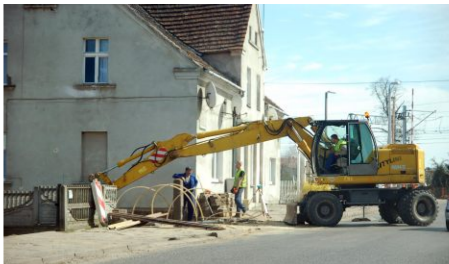
Budowa kanalizacji na ul. Granicznej
