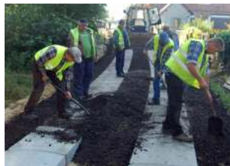
W Strzyżewie powstały kolejne odcinki utwardzonej drogi
