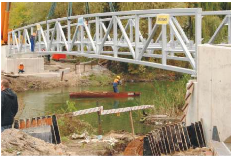
Nowa kładka przed montażem elementów drewnianych
