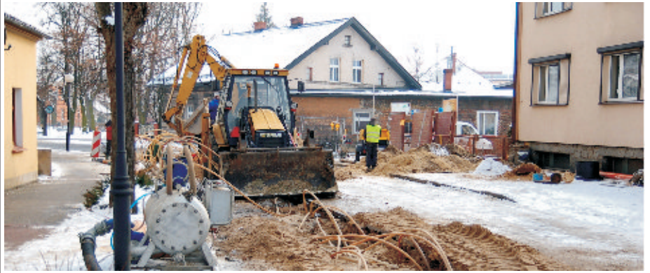
W marcu zakończono budowę sieci kanalizacyjnej na ulicy 17-go Stycznia
