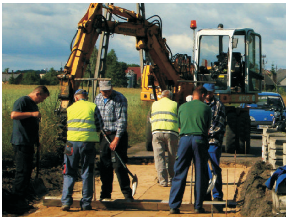
W ubiegłym roku utwardzono kilkaset metrów drogi w Nowym Dworze
