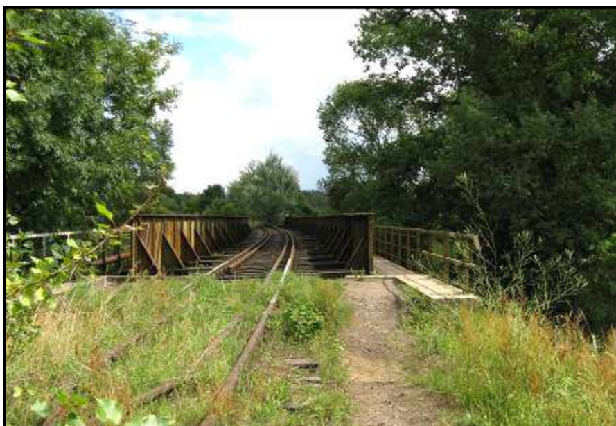
Zdjęcie nr 26. Nieczynny most kolejowy na rzece Obra
