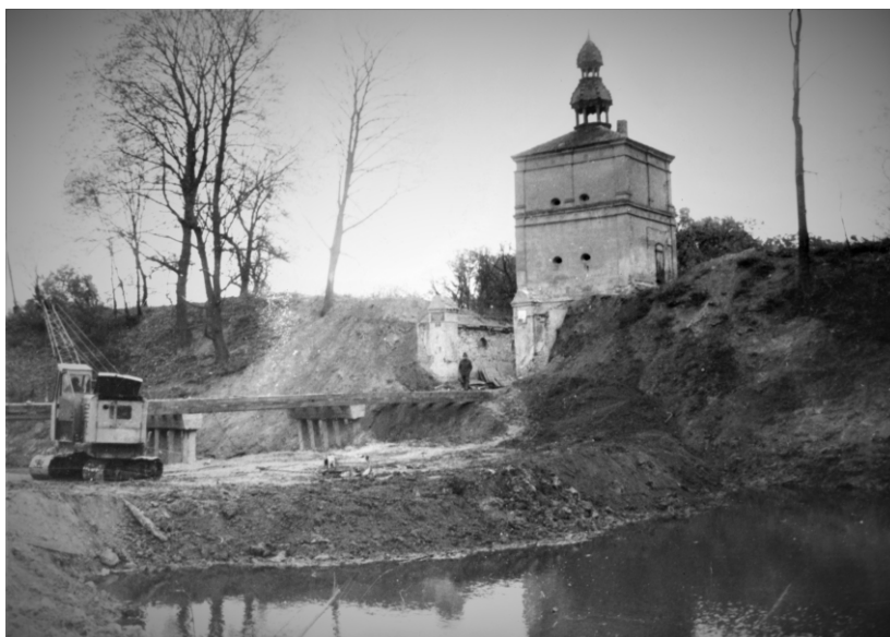
Fot. Remont Wieży oraz fosy. Zbąszyń 1982 rok.
