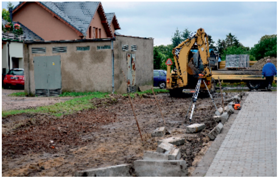
Trwa budowa parkingu przy Bibliotece
