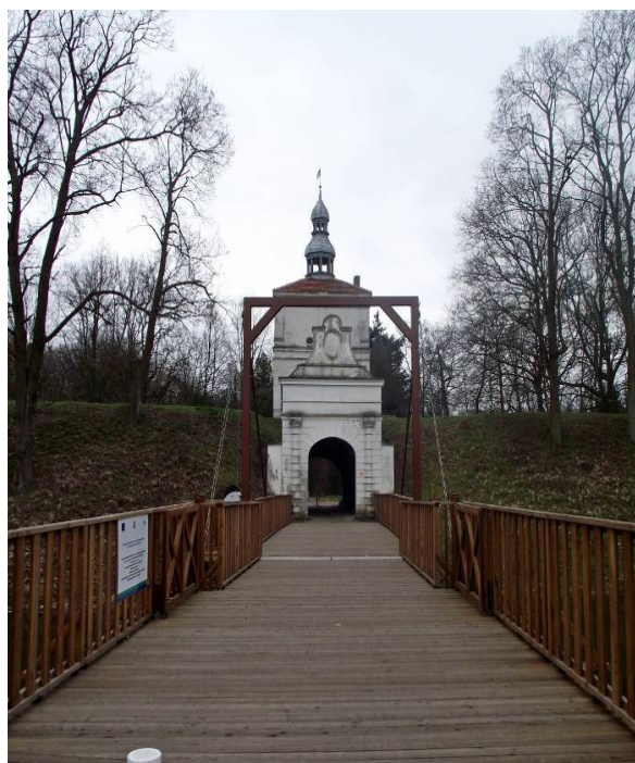
Most prowadzący na teren dawnej twierdzy po przebudowie w latach 2016 -2018 (Widoczne przęsło ze zwodzonym mostem.)
